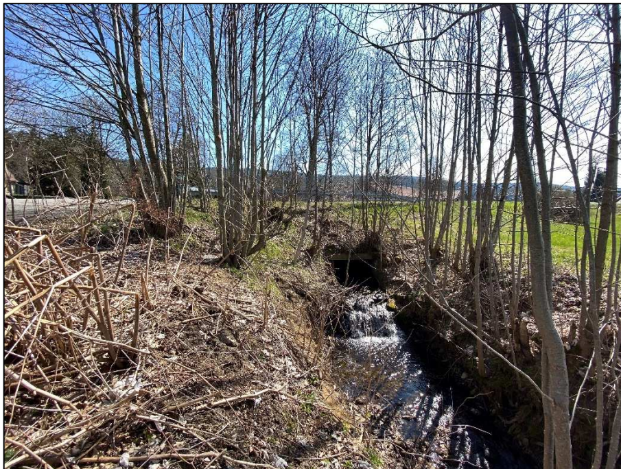
Blick auf den Rohrdurchlass Breithausbach unterstrom der Ortsstraße.
