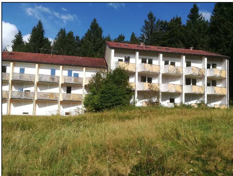
Zimmertrakt im Südosten von Westen aus gesehen. Brachliegende Freiflächen.
