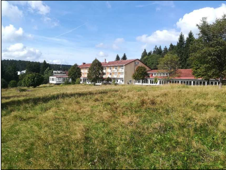
Blick über die brach liegenden Freianlagen von Süden nach Norden auf den Hotelkomplex.
