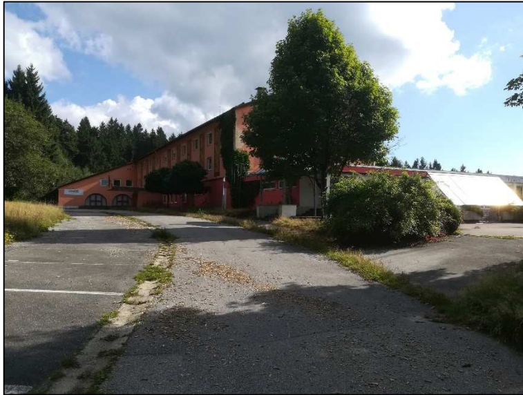
Zufahrt zum Hotel mit Vorbereich, rechts Terrasse auf Tiefgarage
